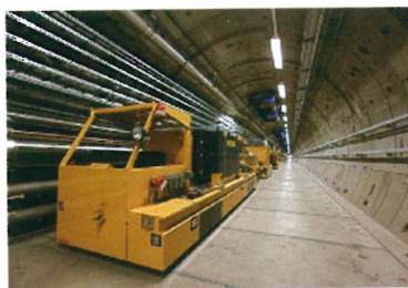
XFEL 加速器地下トンネル
