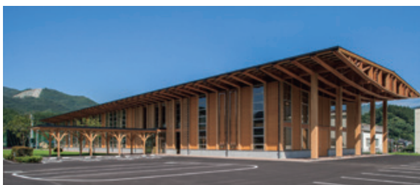
地域産木材で建築した岩手県住田町役場
